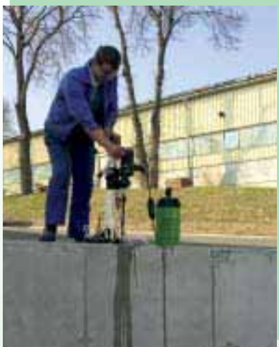
Serienbohrungen mit BST 90 und Diamant-Nass-Bohrmaschine END 1521 P
